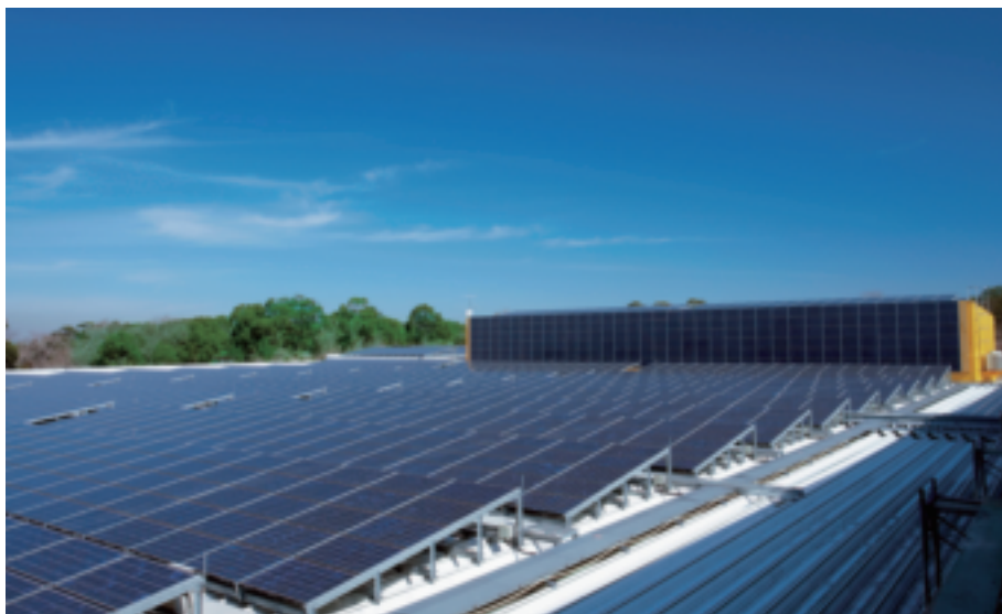
屋頂架設約1萬6,000片太陽能發電板，總面積達1萬2400平方米，是全日本最大規模的太陽能發電系統。
