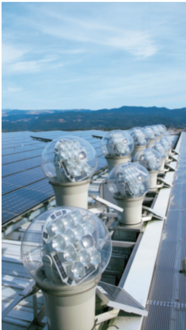
「向日葵」集光器能自動偵測陽光方位，機器跟隨太陽的方向而轉動，以收集最多的陽光。
